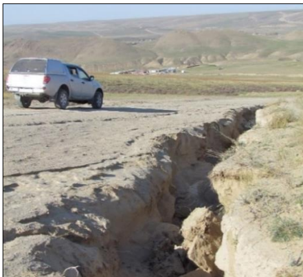
Рисунок 1.1 – Эрозионные формы размыва по полотну и кюветам грунтовых дорог на хребте Малайсары
