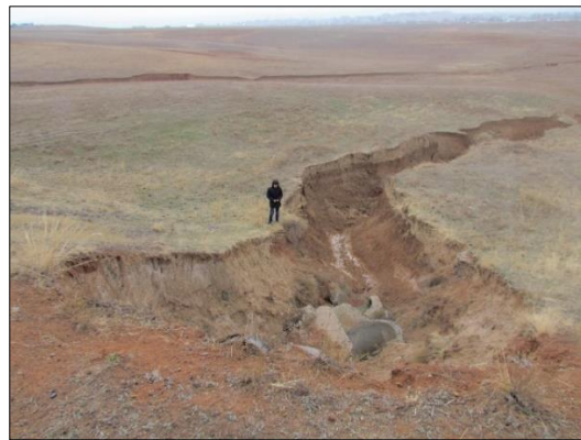
Рисунок 1.2 – Образование оврагов вдоль автодороги Сарыюзек-Жаркент в 1 км восточнее с. Сарыюзек
