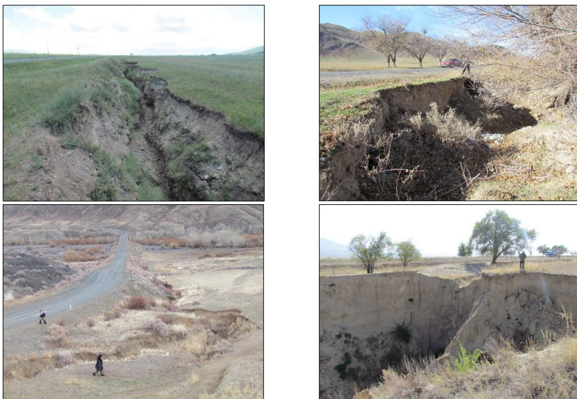
Рисунок 2.4 – Кюветные овраги Жетысу вдоль автодорог
