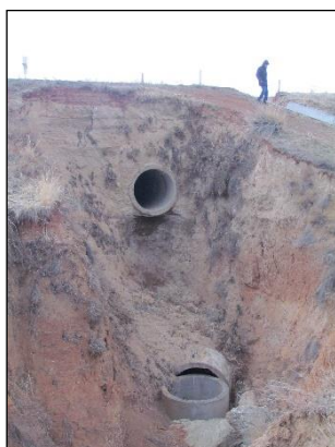
Рисунок 2.3 – Разрушенная водопропускная труба на 2,1 км автодороги Сарыозек-Хоргос
