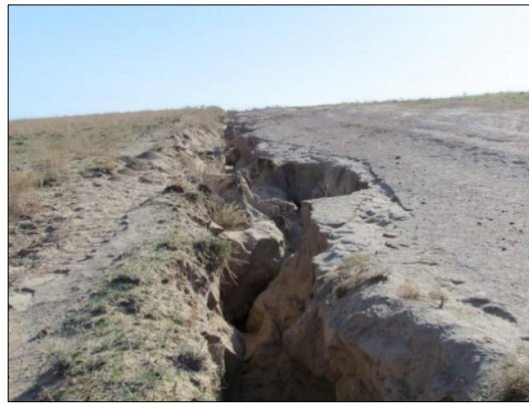
Рисунок 1.1 – Эрозионные формы размыва по полотну и кюветам грунтовых дорог на хребте Малайсары
