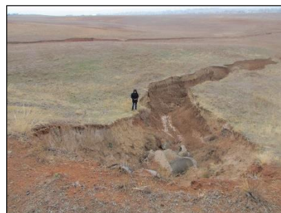
Рисунок М.2 – Антропогенные овраги, разрушенная водопропускная труба на 1,7 км автодороги Сарыозек-Хоргос
