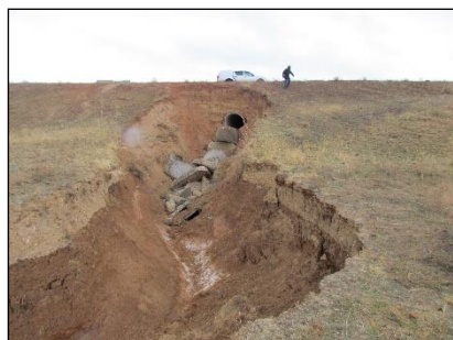
Рисунок М.2 – Антропогенные овраги, разрушенная водопропускная труба на 1,7 км автодороги Сарыозек-Хоргос
