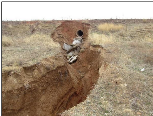
Рисунок 1.2 – Образование оврагов вдоль автодороги Сарыюзек-Жаркент в 1 км восточнее с. Сарыюзек
